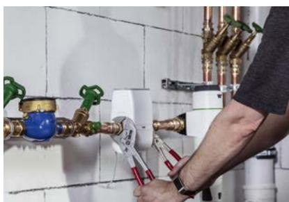
5. Installation de la vanne RE.GUARD sur le réseau, après le compteur et avant le système de filtration.
